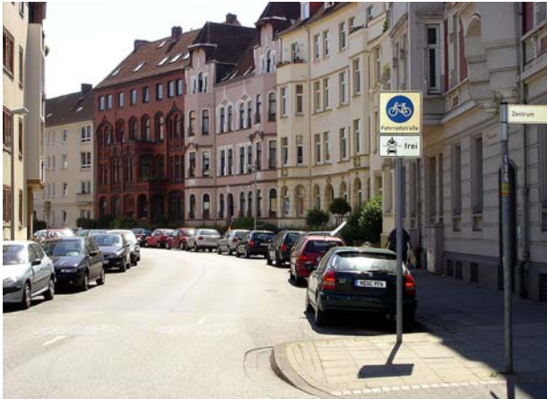
Die Fahrradstraße Stolze Straße, Beispiel für die Förderung des Fahrradverkehrs im Stadtbezirk Südstadt-Bult.
